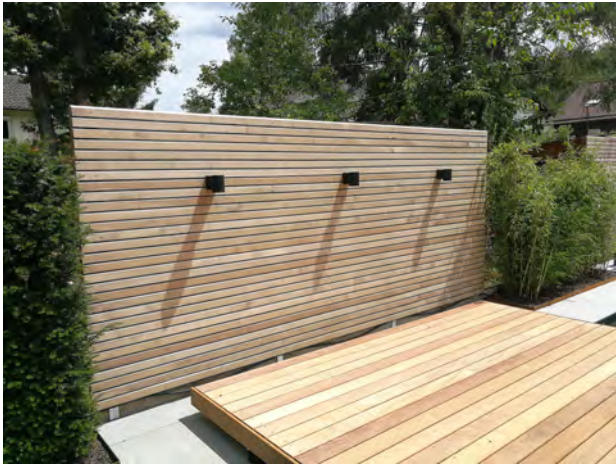
Sichtschutz Lärche Royal an rückseitige Winkelstahlstützen verzinkt
