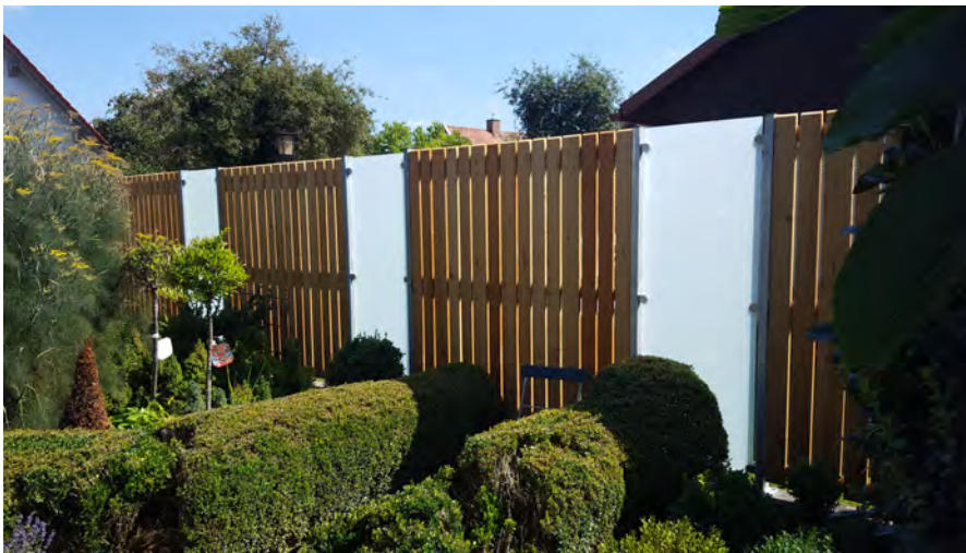
Sichtschutz Lärche Bene und VSG-Glas an Rechteckrohrpfosten verzinkt
