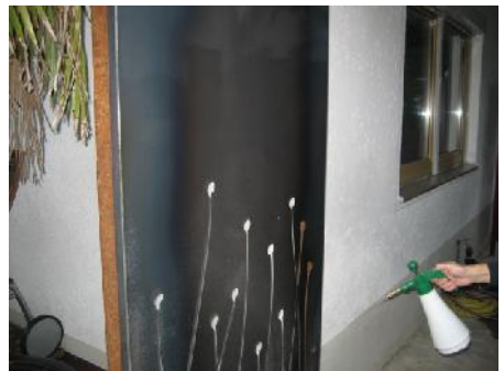
Gleichmäßiges einnebeln der Cortenfläche auf Vorder- und Rückseite, fertig
